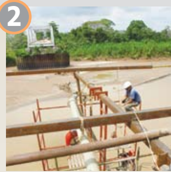
2 Cabezal: con 122 metros cúbicos de concreto, igual a 17.5 camiones, alcanzará un peso de 500 toneladas.
