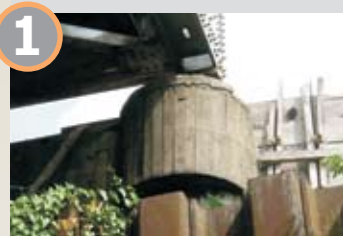
1 Cuatro pilotes en cada una de las bases como refuerzo
