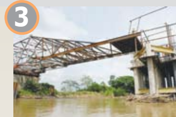
3 Lanzamiento con patines: la estructura metálica se ubica sobre una suerte de patines fijos y móviles.
